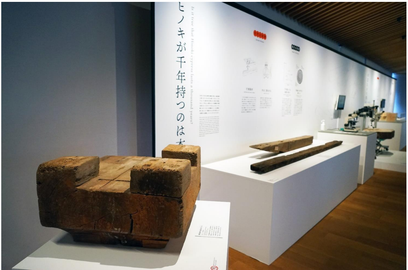
「ヒノキが千年持つのは本当か？」コーナー。千年以上も建築を支え続けてきた建築部材の実物を展示しています（全てヒノキ、唐招提寺蔵）。
