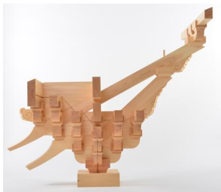
④円覚寺舍利殿組物原寸模型 所蔵：竹中大工道具館
