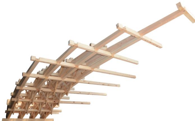
⑤錦帯橋模型 (2.5分の1) 所蔵：竹中大工道具館
