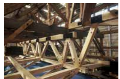
唐招提寺金堂 平成修理の構造補強
