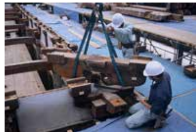
7 | 唐招提寺金堂 組物解体の様子
