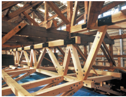
b. 唐招提寺金堂 平成修理の構造補強
