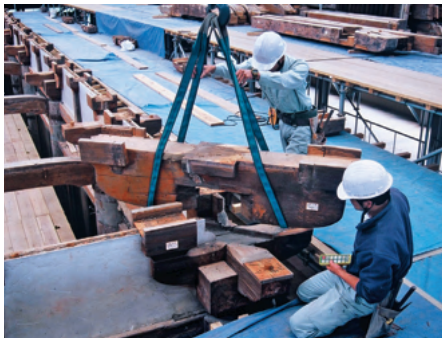
a. 唐招提寺金堂 組物解体の様子
