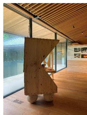
左手は金物を一切使わずに木組だけで組み立てた CLT パビリオンです。
