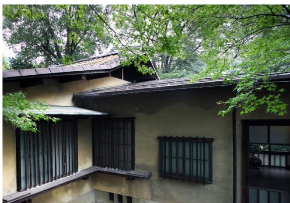
7. 屋根妻面に設けられた通風窓
