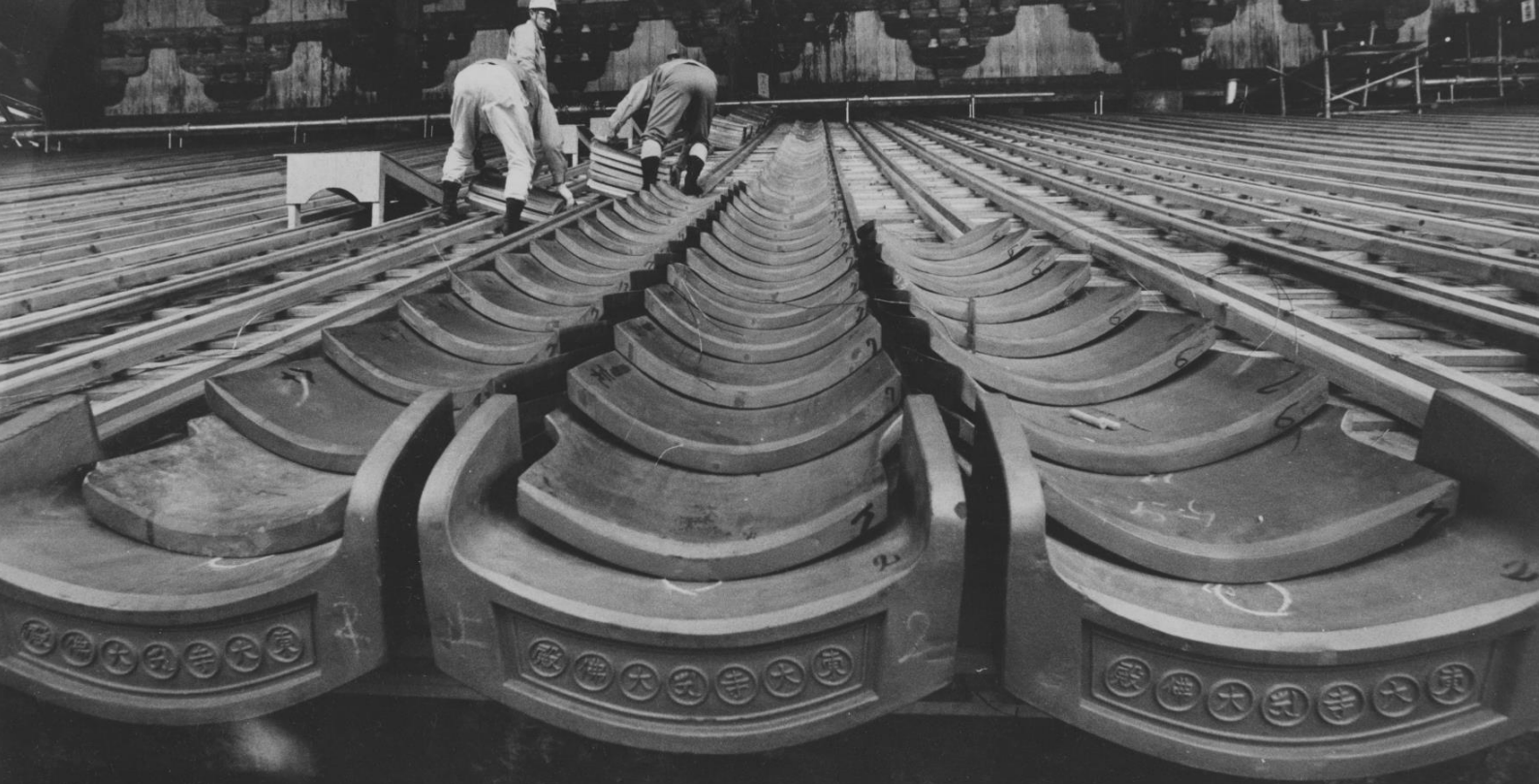
2. 東大寺大仏殿昭和大修理
