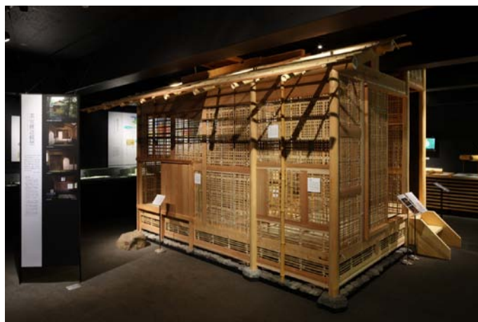
A：茶室構造模型（実物大）
