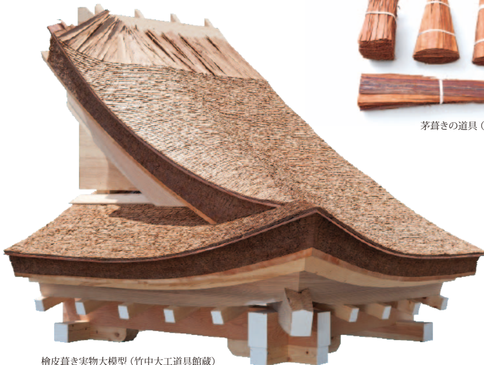
檜皮葺き実物大模型 (竹中大工道具館蔵)
